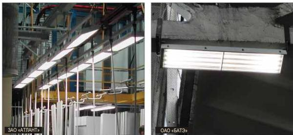
Монтаж на трубу или балку с помощью шпилек и зажимов.
